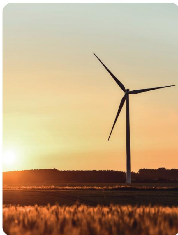
Parc éolien de Mont-de-Bagny (59)
